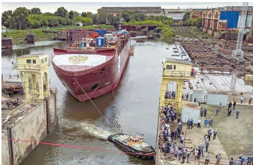
АО «ЦТСС» разрабатывает проекты по реконструкции и техническому перевооружению производства для ПАО «Амурский судостроительный завод»
