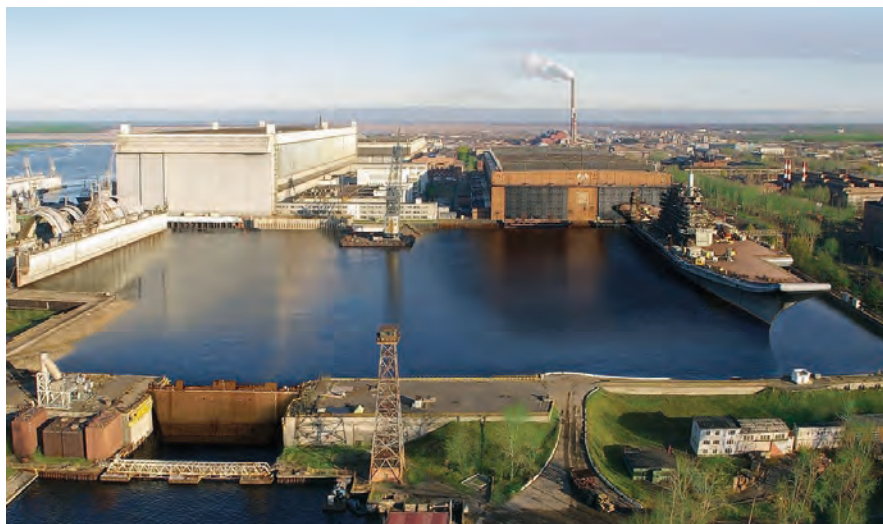
Реконструкция и техническое перевооружение АО «ПО «Севмаш» ведётся по проектам АО «ЦТСС»
